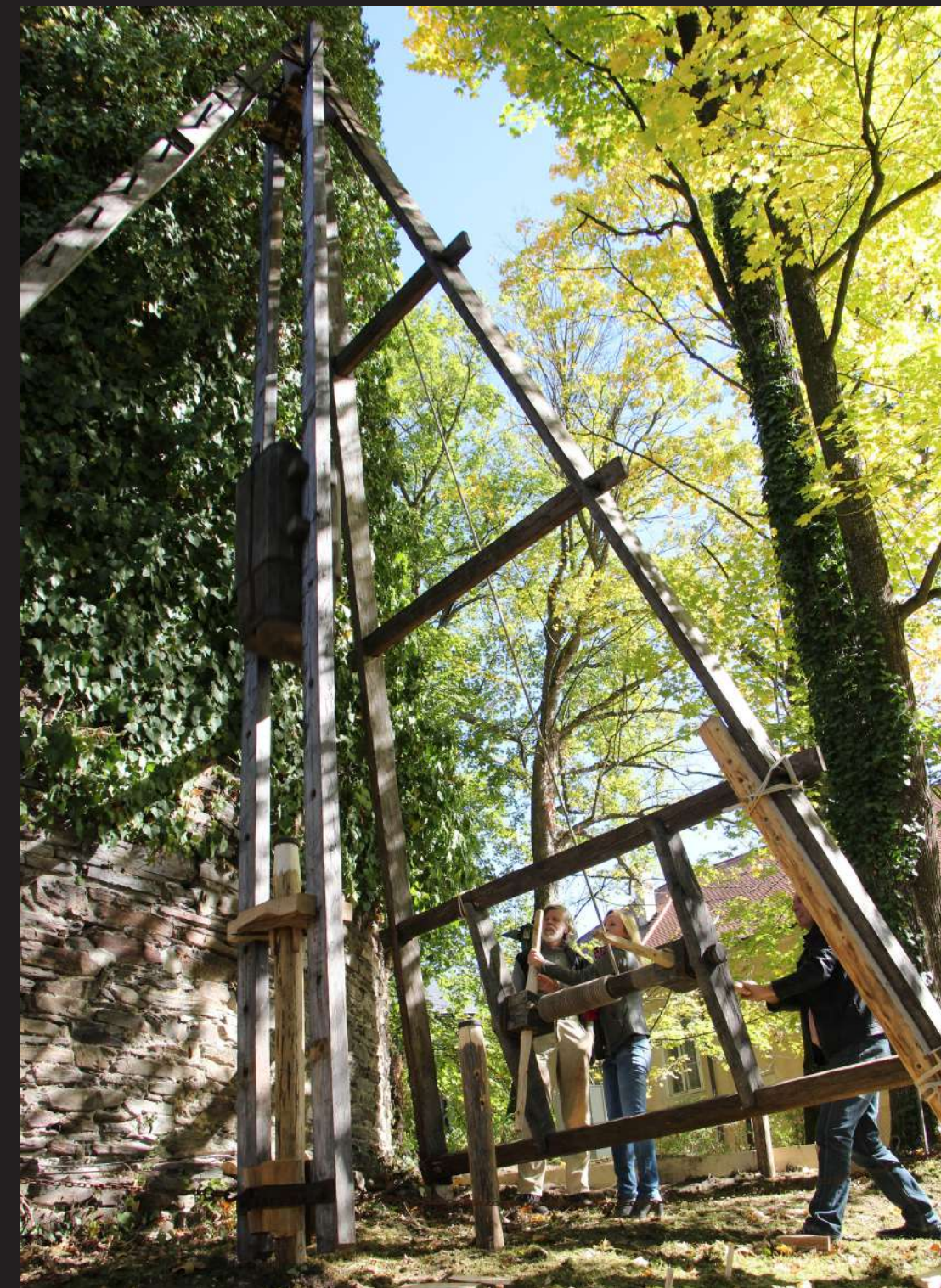
Zaloučení dřevěných kůlů ke zpevnění základů lešení pomocí repliky historického pilotážního stroje, 2015, archiv NPU Hammering of the wooden scaffolding anchors using a replica of an historic piloting device, 2015, NHI archive
