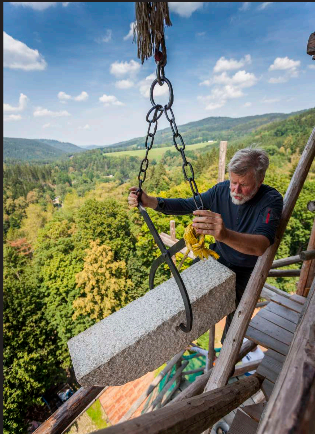
Osazování kamenných konzol na ochozu věže s pomocí rotačního jeřábu, 2019, foto L. Pouzar Installation of the stone consoles on the gallery of the tower with the help of the rotating crane, 2019, photo L. Pouzar
