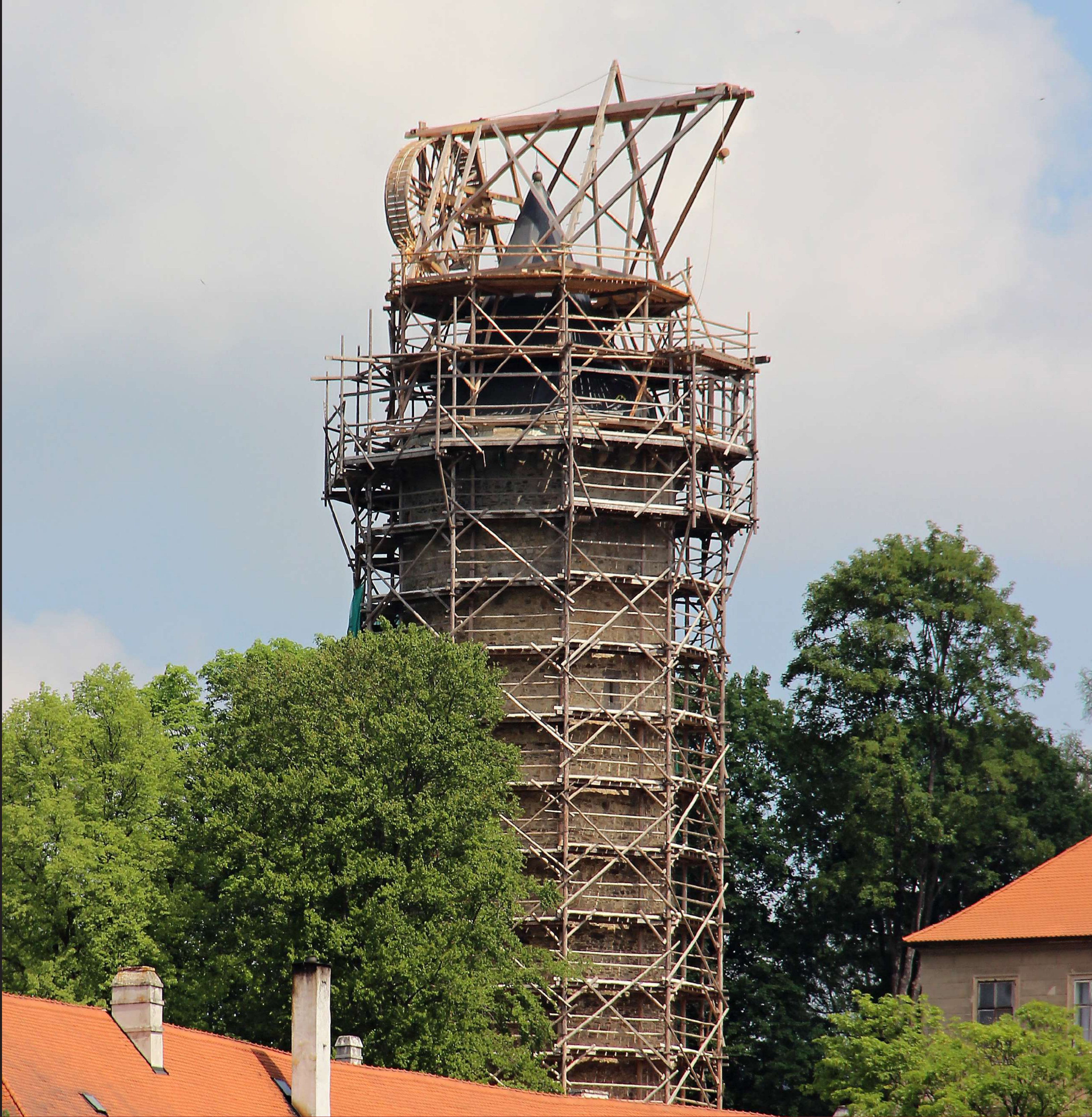
Osazování kamenných konzol na ochozu věže s pomocí rotačního jeřábu, 2019, foto L. Pouzar Installation of the stone consoles on the gallery of the tower with the help of the rotating crane, 2019, photo L. Pouzar
