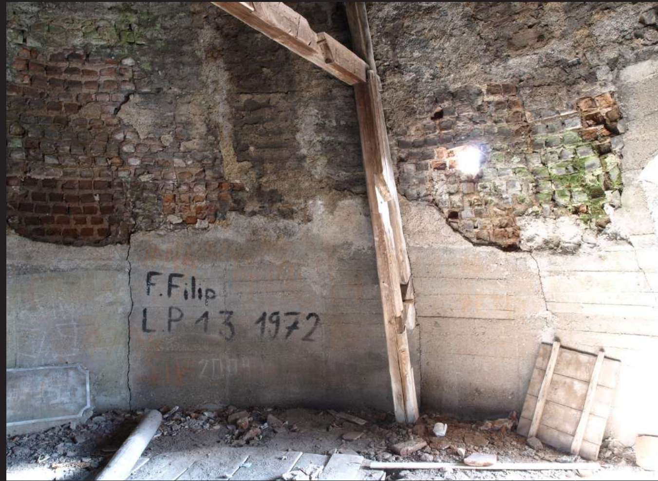
Interiér věže pod cihlovou helmicí, stav před restaurováním, 2012, archiv NPU The interior of the tower under the brick roof, condition before restoration, 2012, NHI archive
