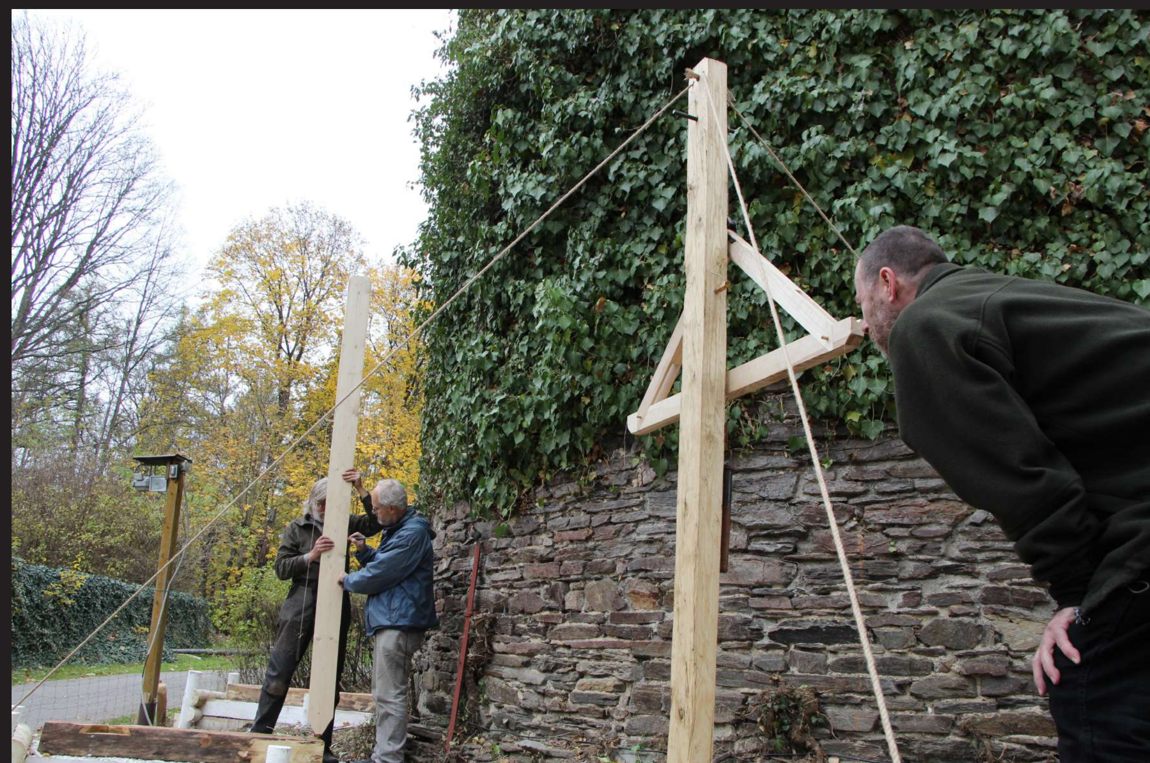
Vměřování základů lešení s užitím historického nivelačního přístroje na principu zavěšené krokyce, 2015, archiv NPU Measurement of the scaffolding foundations with the use of an archipendulum, a historical levelling device based on the principle of a suspended bar, 2015, NHI archive
