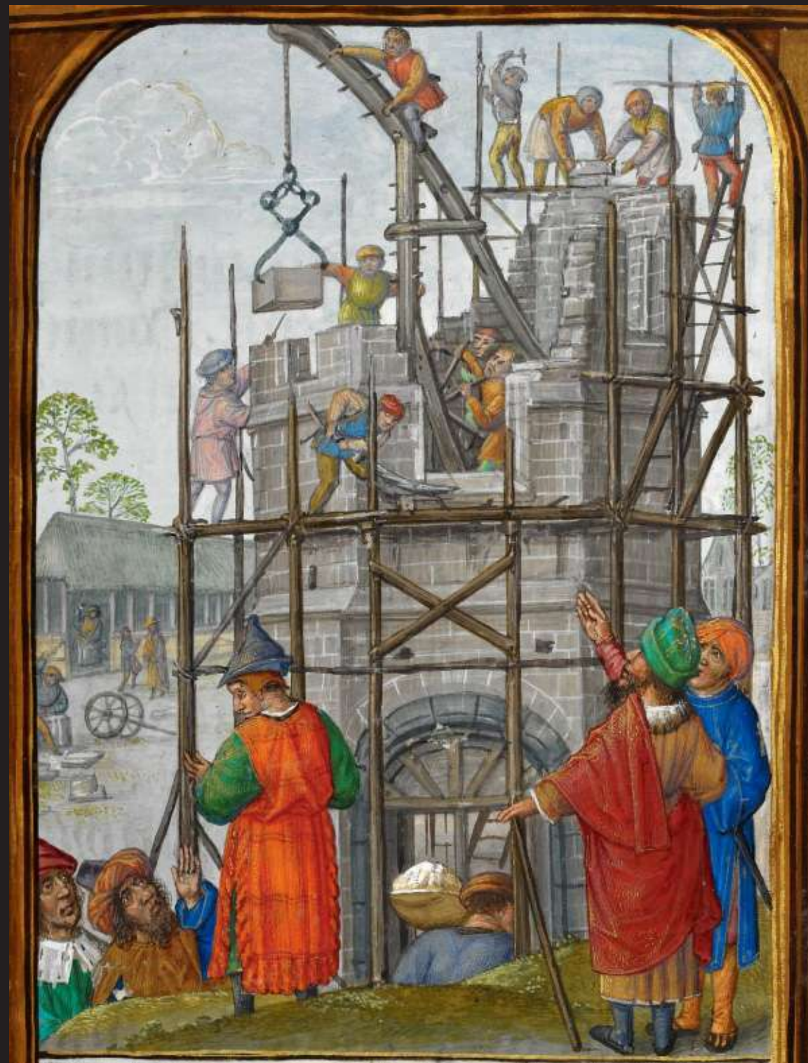
Dva příklady lešení a stavebních strojů ze středověkých iluminovaných rukopisů 14.–15. století, archiv NPU Two examples of scaffolding and construction machines from medieval illuminated manuscripts of the 14th–15th centuries, NHI archive
