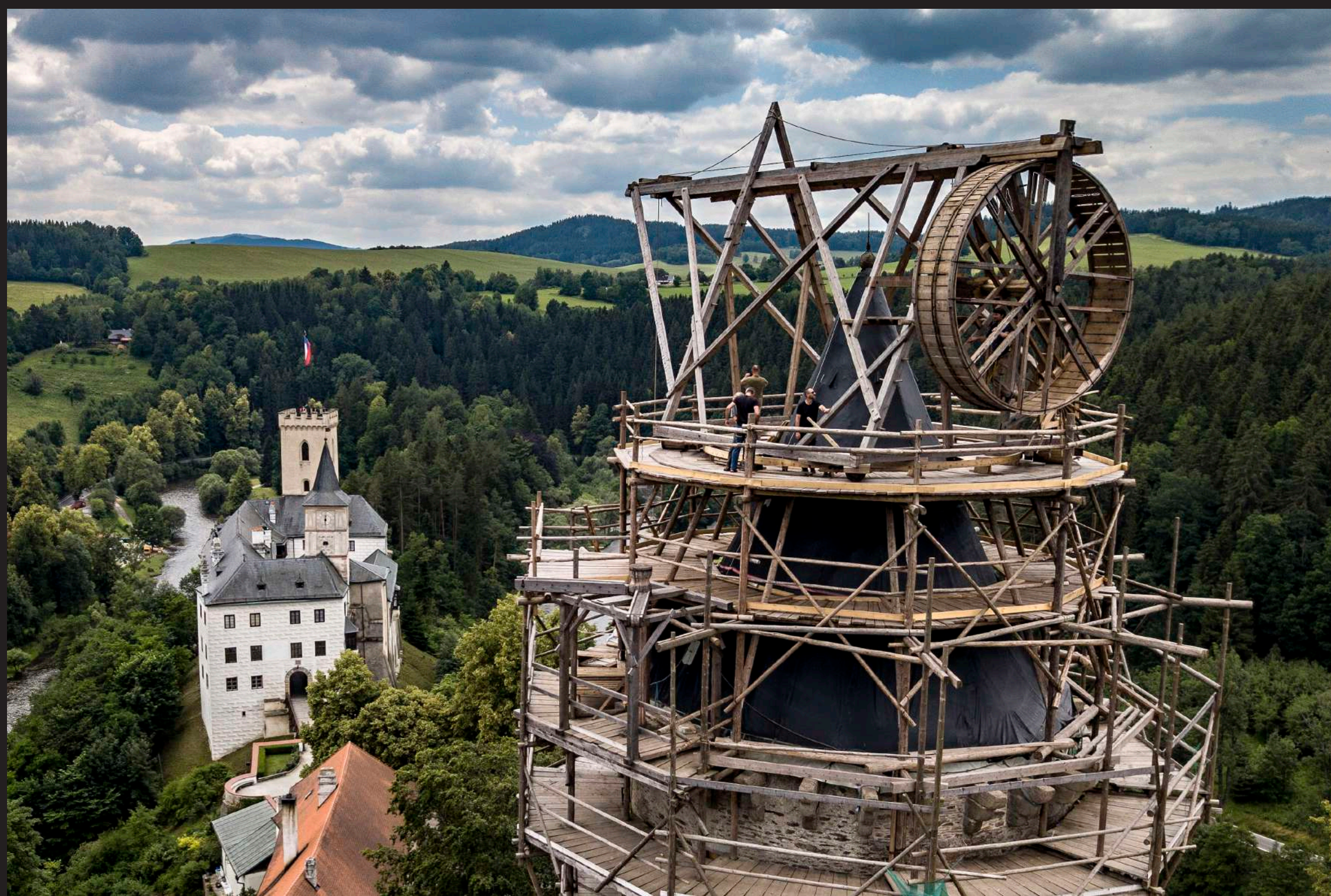
Pohled na rotační jeřáb na vrcholu věže Jakobínky, 2019, archiv NPU A view of the rotating crane on the top of Jakobínka, 2019, NHI archive
